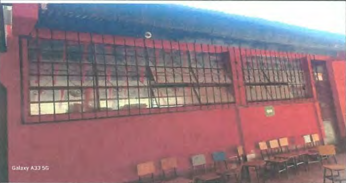
Foto 3: Reforzamiento e instalacion de ventanas en el aula de segundo grado 3.50mIs de ancho al cuadrado
