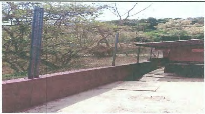
Foto 2: Mejoramiento y continuacion del muro perimetral con mamposteria
