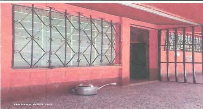
Foto 4: Reforzamiento e instalacion de ventanas en la direccion 1.90 de largo 1.57 de ancho al cuadrado
