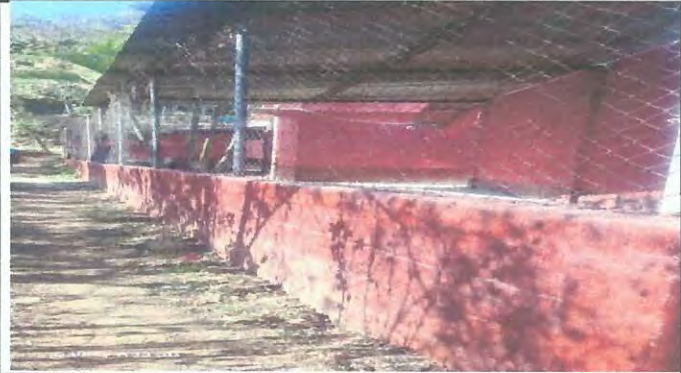
Foto1: Mejoramiento y continuacion del muro perimetral con mamposteria
