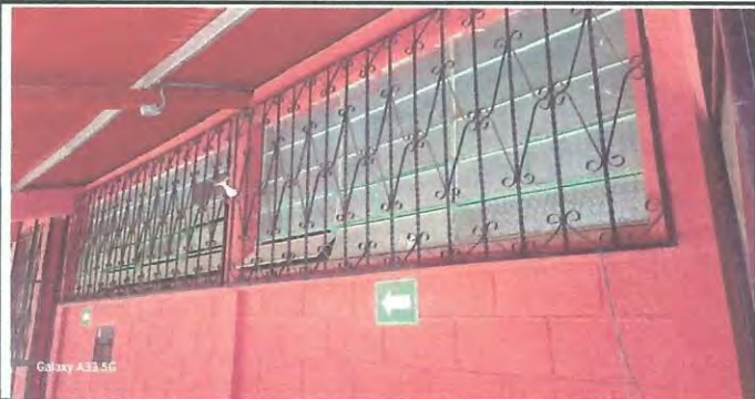
Foto 5: Reforzamiento e instlacion de ventanales en el aula de sexto grado 3.57de largo y 1.57 de ancho al cuadrado
